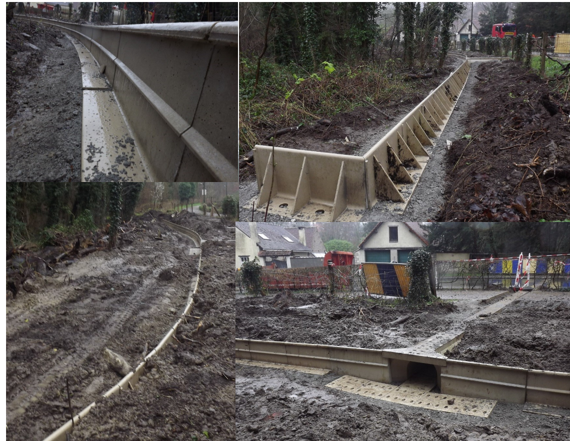
Le chantier du crapauduc en date du 6 mars 2020
